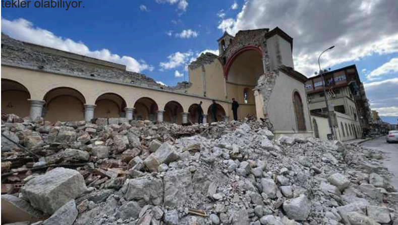
Şekil 5. Hasar İzlerinin Yok Olmadan ve Enkazın Çevresi Temizlenmeden Önceki Durum (Fotoğraf: Zeynep Gül Ünal).
