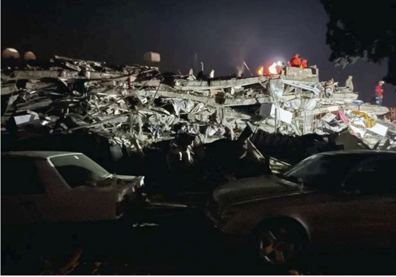
Şekil 2: Korkmaz Apartmanı - Antakya (Fotoğraf: Ömer Selçuk Baz).
