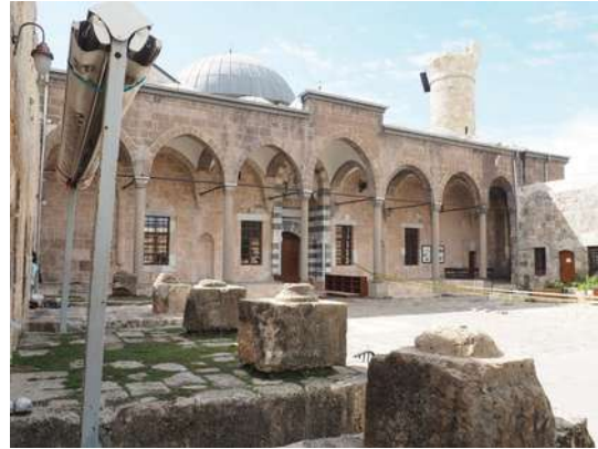
Şekil 10. Payas, II. Selim Camii'nin 2023 Depremi Sonrası Durumu (sağda) (Fotoğraf: Zeynep Ahunbay).
