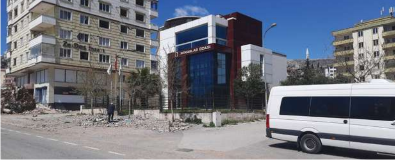
Şekil 12. Deprem Sonrası Kahramanmaraş Mimarlar Odası Binası, Şubat 2023. (Fotoğraf: Ali Tolga Özden).
