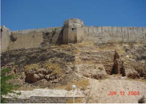
Şekil 6. Gaziantep Kalesi, 2004 (solda) (Fotoğraf: Zeynep Ahunbay).
