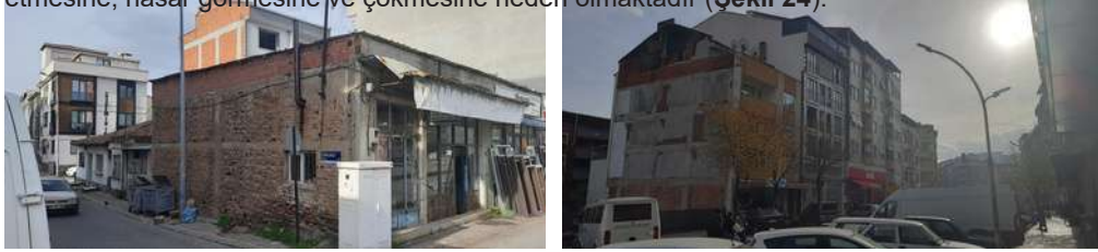
Şekil 24. Nitelsiz Yapıların Ve Ruhsatsız-Projelendirilmemiş İlave Katların Oluşturduğu Riskler (Fotoğraflar: Ali Tolga Özden).
