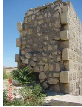
Şekil 7. Gaziantep Kalesi Restorasyonundan Ayrıntı, 2004 (sağda) (Fotoğraf: Zeynep Ahunbay).
